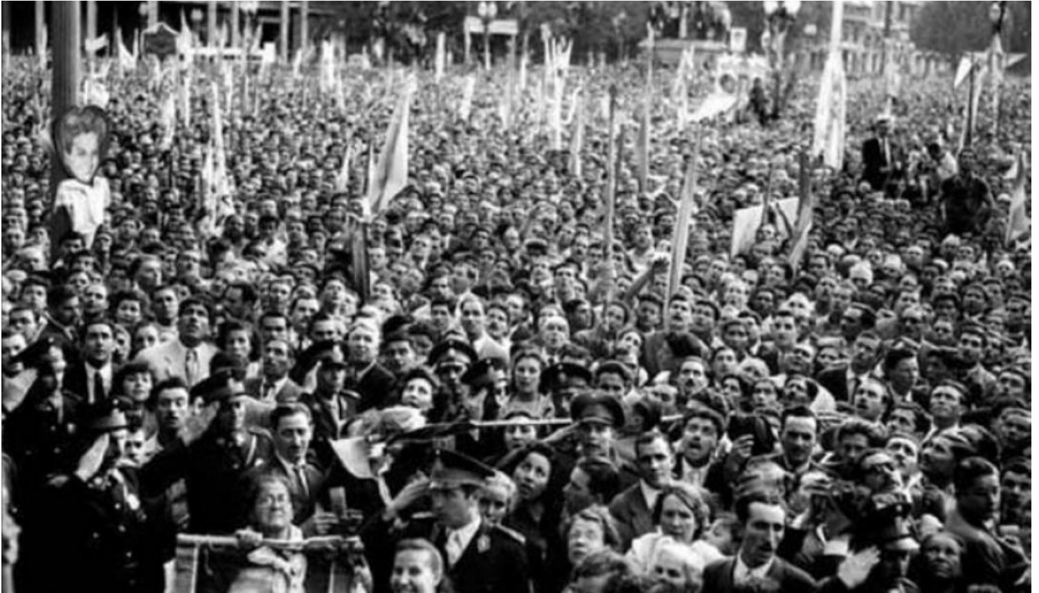
Huelga de obreros de la construcción. Buenos Aires, enero de 1936.
